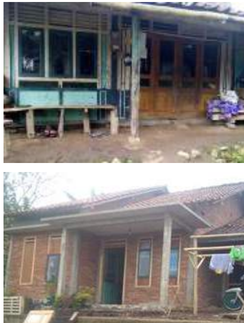
Gambar 4. 5. Kondisi awal rumah dan setelah direnovasi
