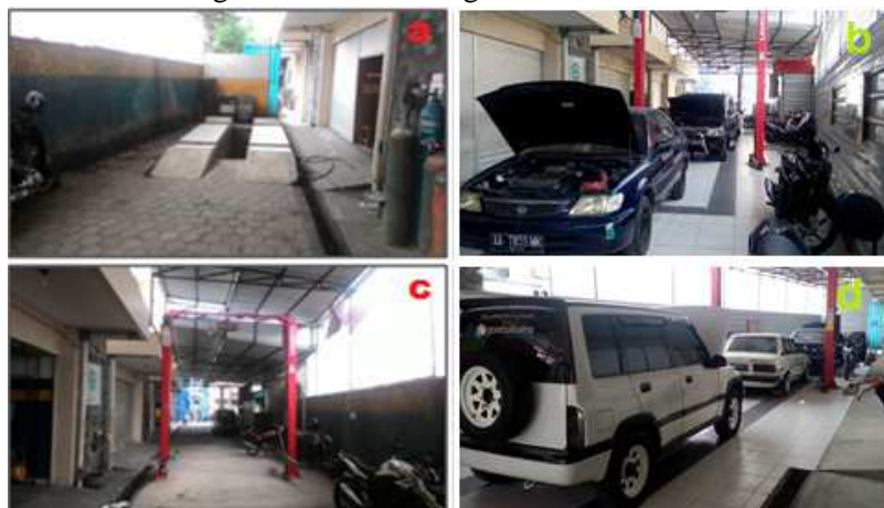
Gambar 4. Lingkungan Bengkel (a,c) Belum Dilakukan Renovasi, Sedangkan (b,d) Setelah Dilakukan Renovasi.
