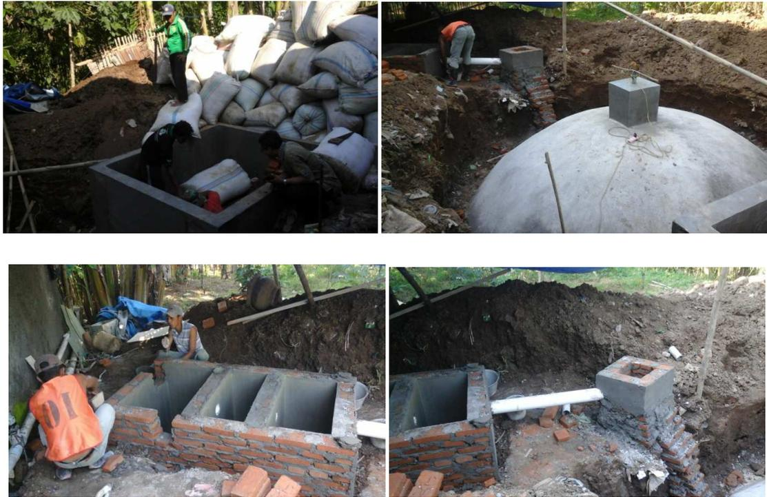
**Gambar 4. Pembuatan Biodigester**
