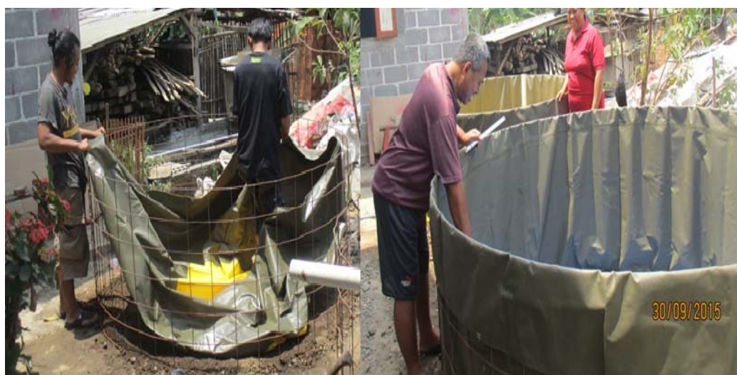
Gambar 5. 10 Pemasangan Terpal
