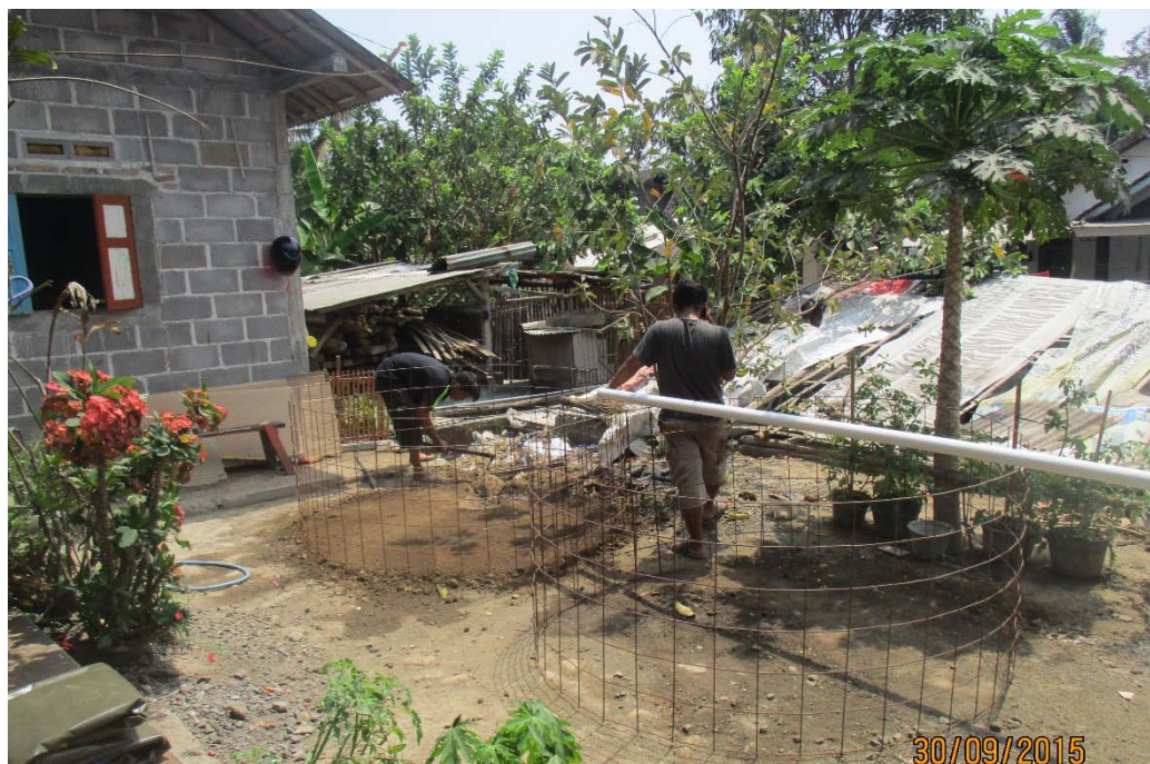
Gambar 5. 9 Pemasangan Frame Terpal
