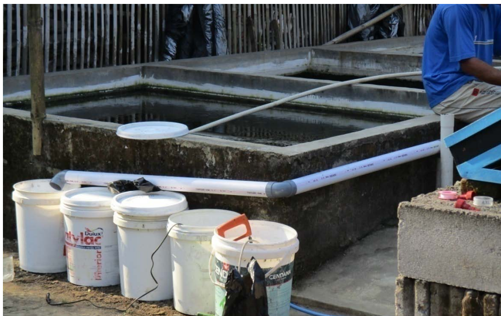
Gambar 5. 6 Set up unit penjernih air
