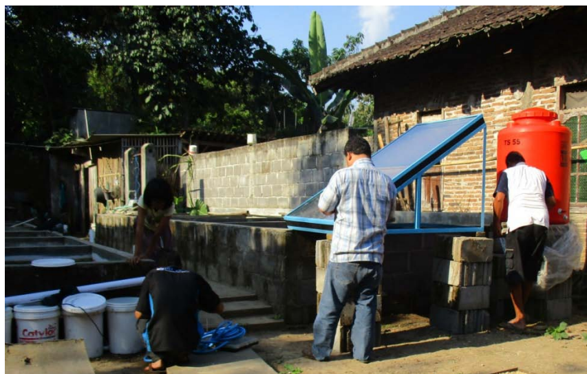
Gambar 5. 7 Perbaikan dan penyempurnaan unit penjernih air
