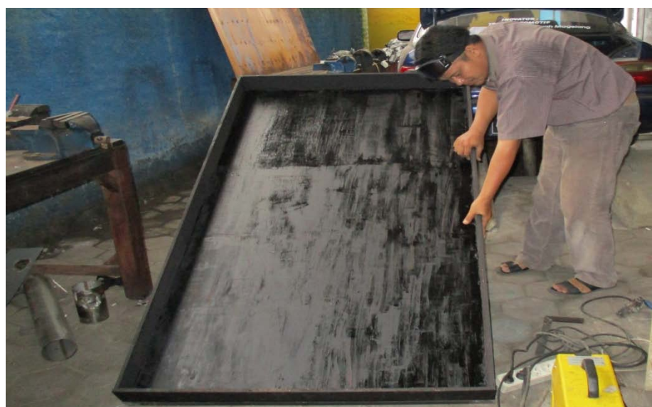
Gambar 5. 3 Pemasangan kotak Solar Water Heater
