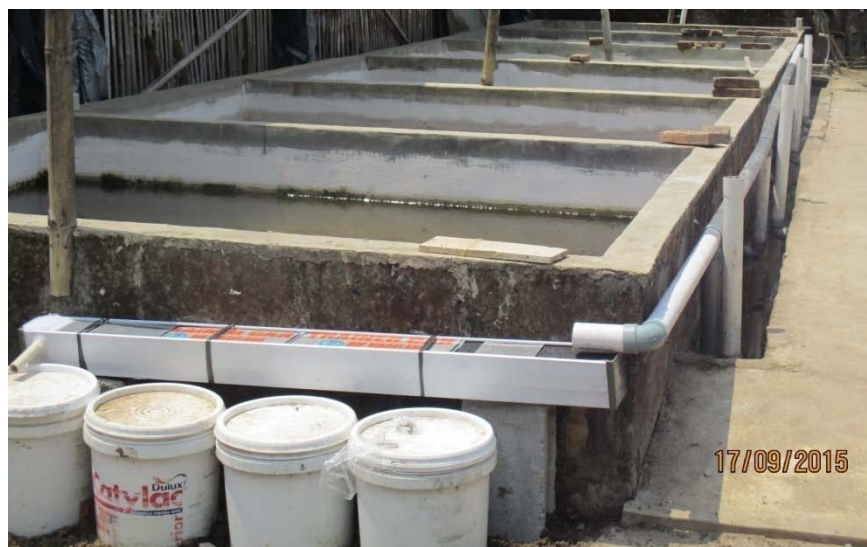
Gambar 5. 7 Perbaikan dan penyempurnaan unit penjernih air
