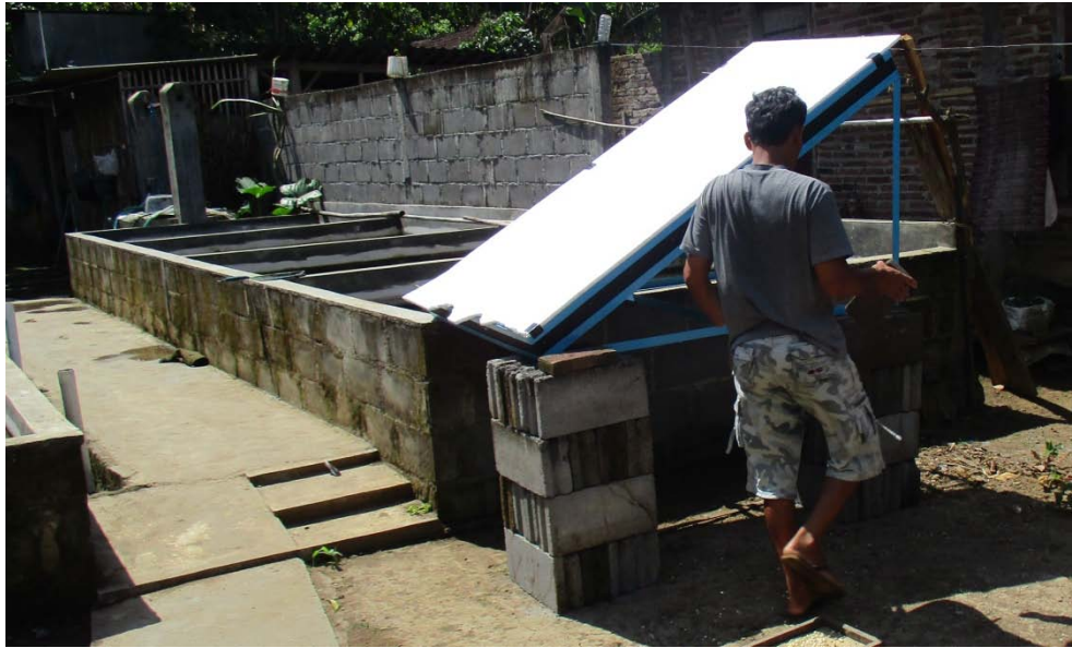
Gambar 5. 5 Proses penempatan Solar Water Heater
