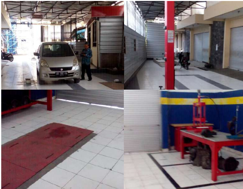
Gambar 5.1 Renovasi Bengkel Yang Telah Dilaksanakan.
